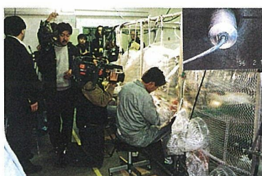
写真1 切断前の温度計鞘管破損部とプラバックの外からの切断作業
